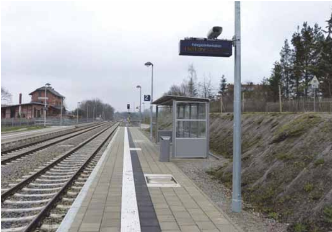
Abbildung 12: Station Oberweimar, Bahnsteig 2 (Quelle NVS)
